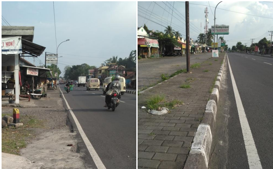
Gambar 45. Sebagian kondisi eksisting di Jalan Magelang km 14 sampai 18 yang belum ada jalur hijaunya.
