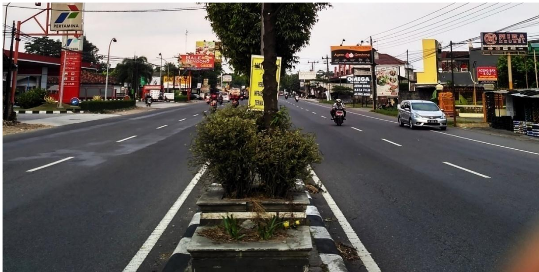
Gambar 4. Kondisi fisik jalan Solo km 7 sampai 14
