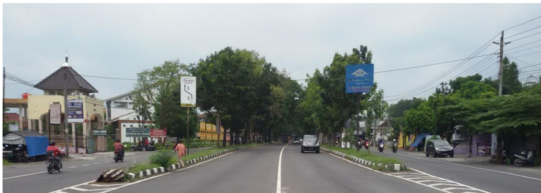
Gambar 6. Kondisi fisik jalan Solo km 15 Bogem
