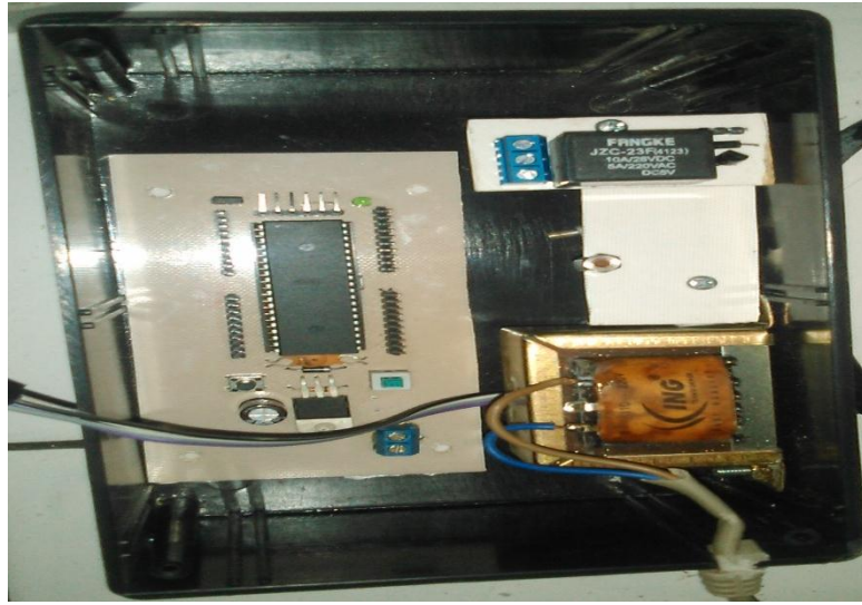
Proses Pemasangan Trafo1 Ampere
