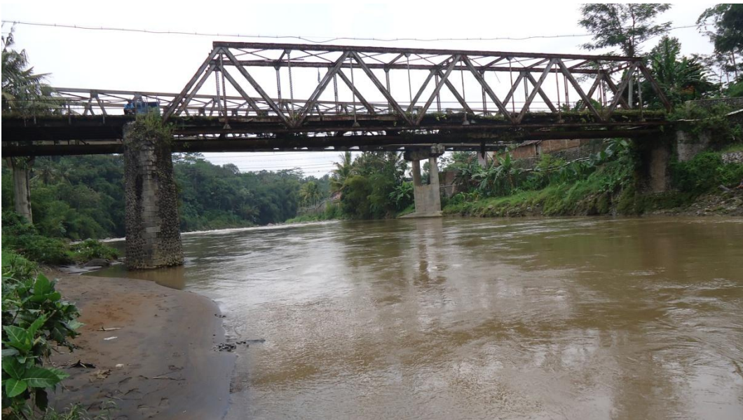
Sedimentasi pada jaringan sungai Banjarnegara
