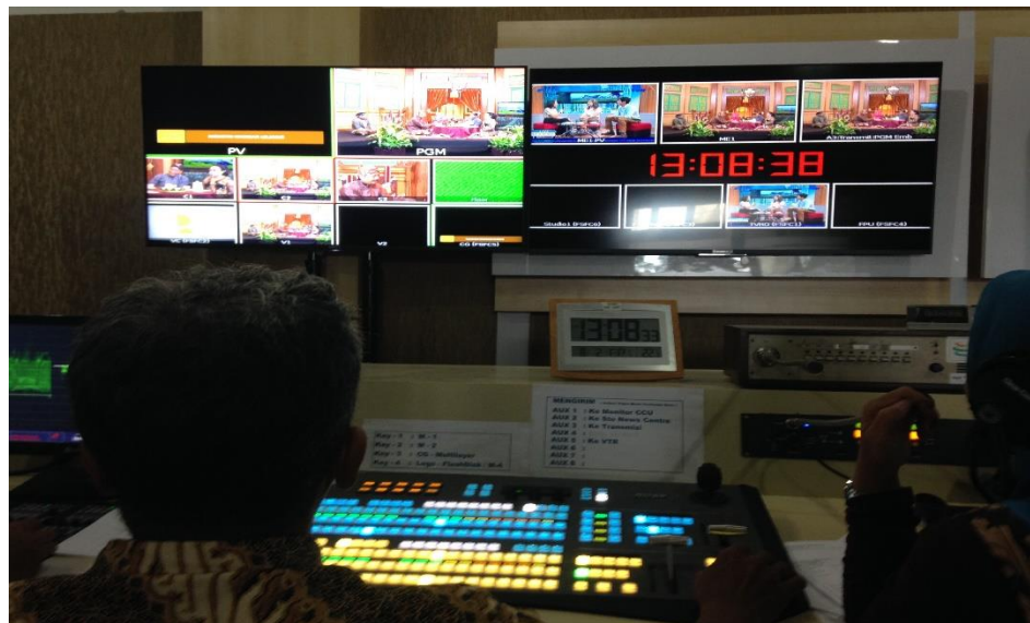
Gambar 3.3 Suasana Ruang Kontrol
