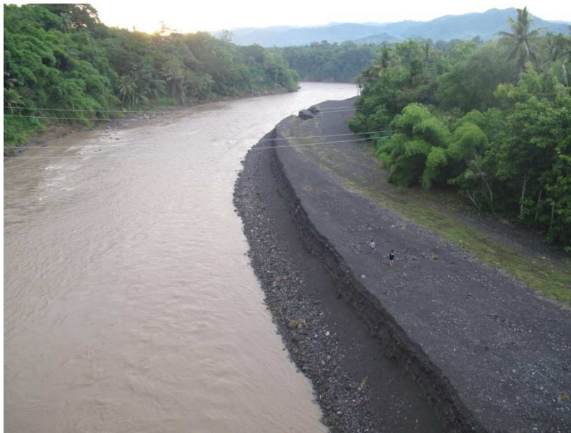
Gambar 1.5 Sedimentasi yang terjadi di hilir Jembatan Kebon Agung II
