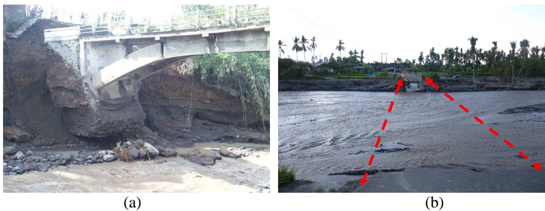
Gambar 2.6 Erosi pada jembatan Srowol (a) Erosi pada sisi abutmen jembatan, (b) Putusnya jembatan Srowol
