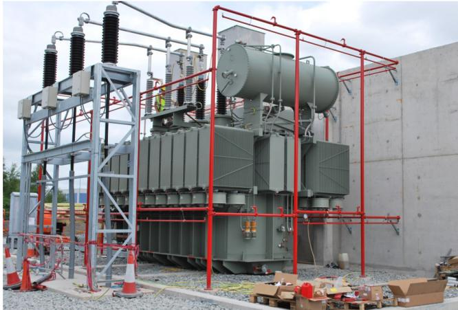
**Gambar 2.11 Transformator pada pembangkit**
