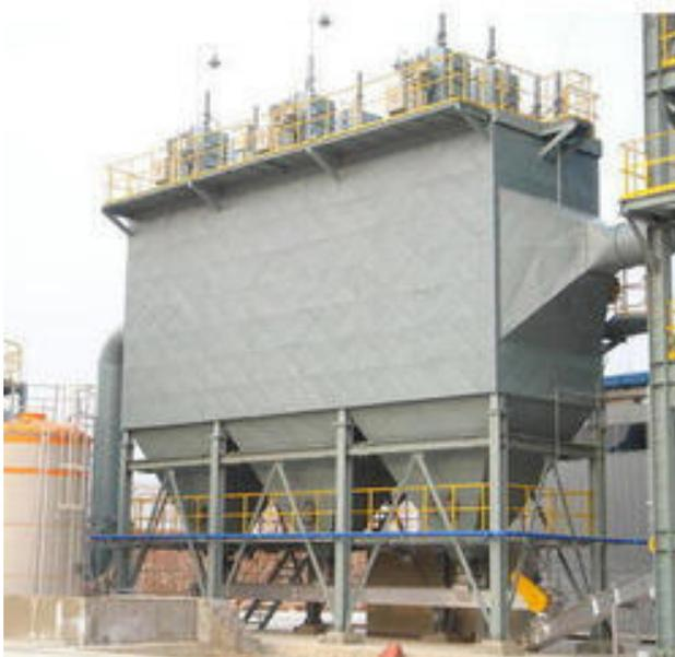
**Gambar 2.12** Penangkapan abu (*electrostatic precipitator*)
