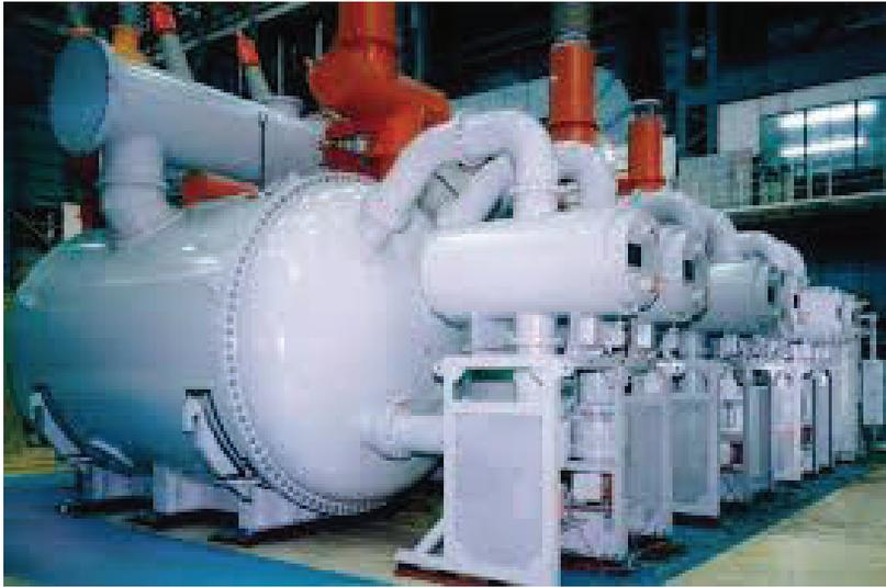
Gambar 8.1 Transformator tenaga berisolasi gas SF<sub>6</sub> pada gardu induk pasangan dalam
