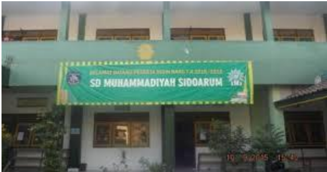
Gedung sekolah SD Muhammadiyah Sidoarum Yogyakarta
