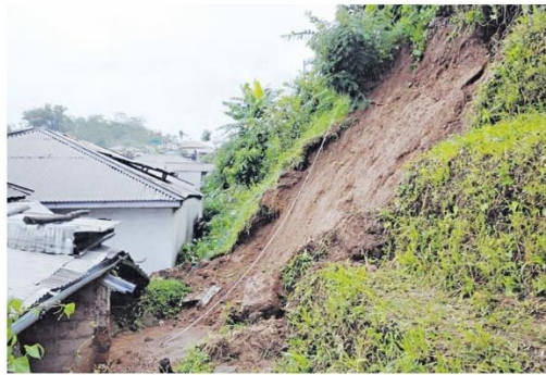
Tebing setinggi 10 meter longsor dan menerjang rumah warga Dusun Krangean, Banyukembar, Watumalang, Wonosobo.
