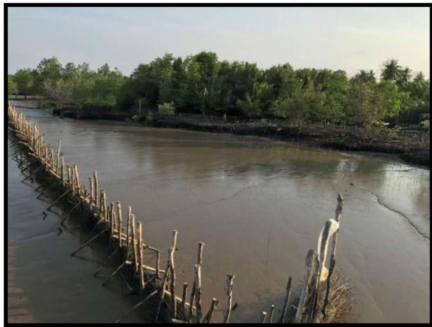
Gambar 3.4 Pembuatan Tanggul Penahan Ombak
