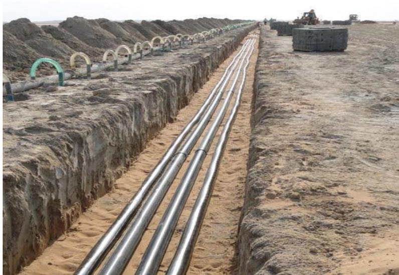
Gambar 2. 4 Saluran Kabel Tegangan Menengah
