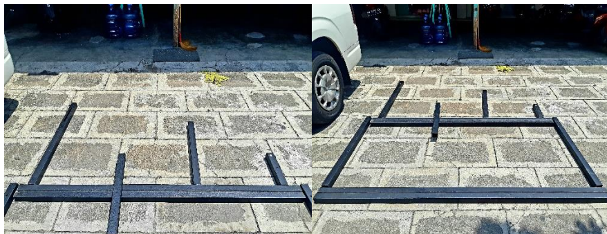
Gambar 4.6 Potongan Besi Hollow yang sudah disesuaikan
