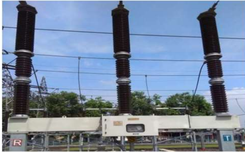
Gambar 2. 6 Bentuk fisik Pemutus Tenaga
