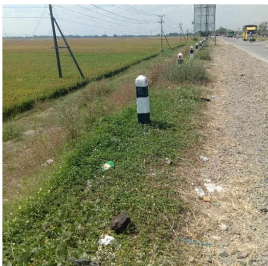
Gambar 18. Bahu jalan yang sempit dan lahan pinggir jalan lebih rendah
