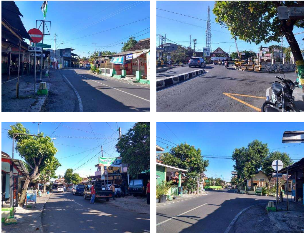
Gambar 13. Kondisi Jalan Jogoyudan
