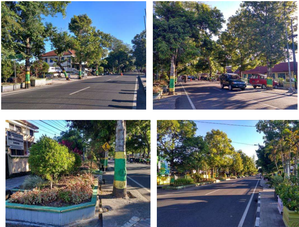
Gambar 11. Kondisi Jalan Sugiman
