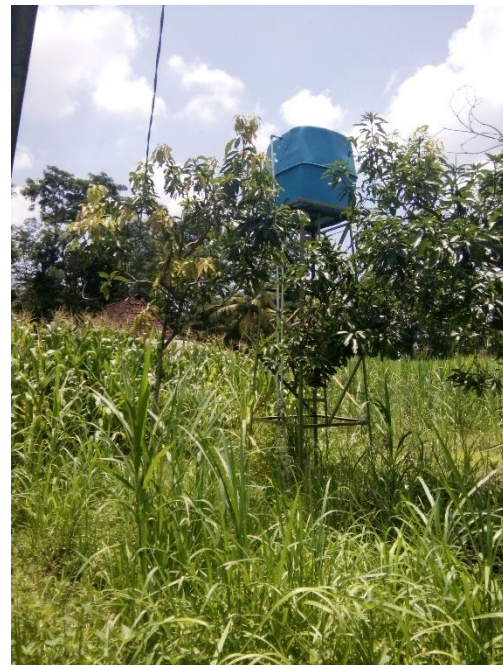
(Instalasi Air: Tangki Air)
