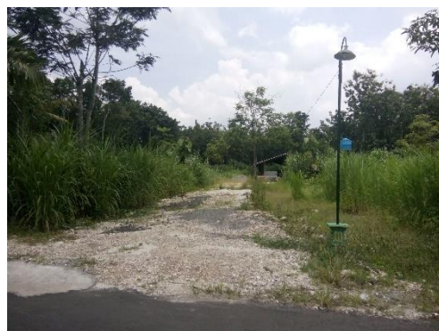
(Instalasi Listrik: Lampu)
