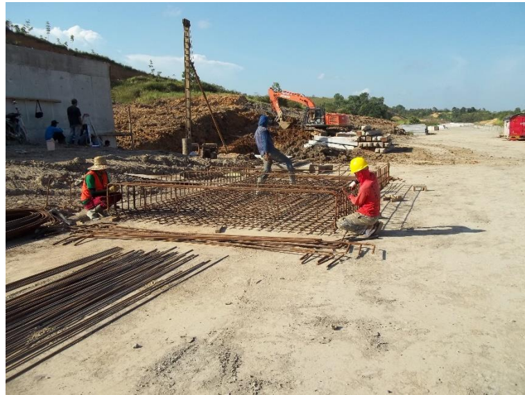
Gambar 4.22 Pembesian pondasi
