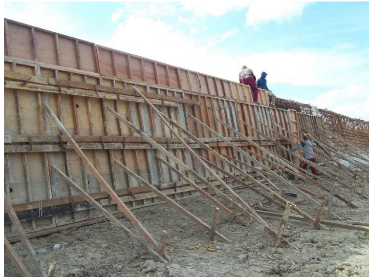
Gambar 4.34 Pemasangan bekisting struktur
