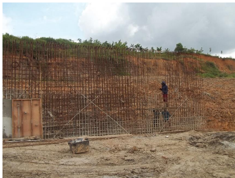
Gambar 4.31 Pembesian struktur
