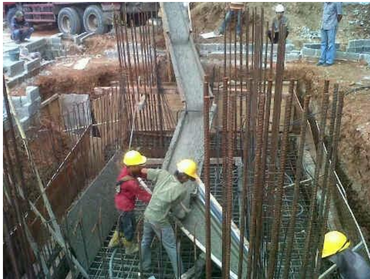
Gambar 4.27 Ilustrasi pengecoran pondasi
