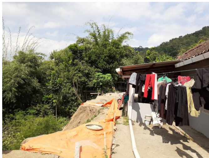
Gambar 5. Lokasi longsor di RT 2 Dusun Mojosari
