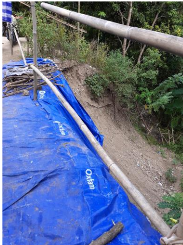
Gambar 7. Lokasi Longsor di Dusun Kemloko
