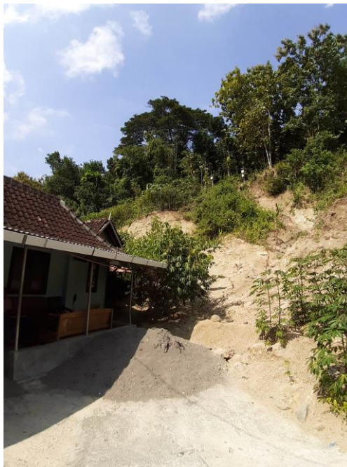
Gambar 3. Lokasi Rawan Longsor di Dusun Tambalan
