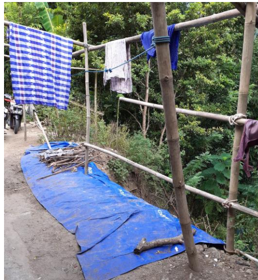
Gambar 17. Terpal pada rekahan tanah
