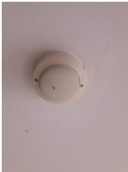
Gambar 4. 21 Deteksi Asap
