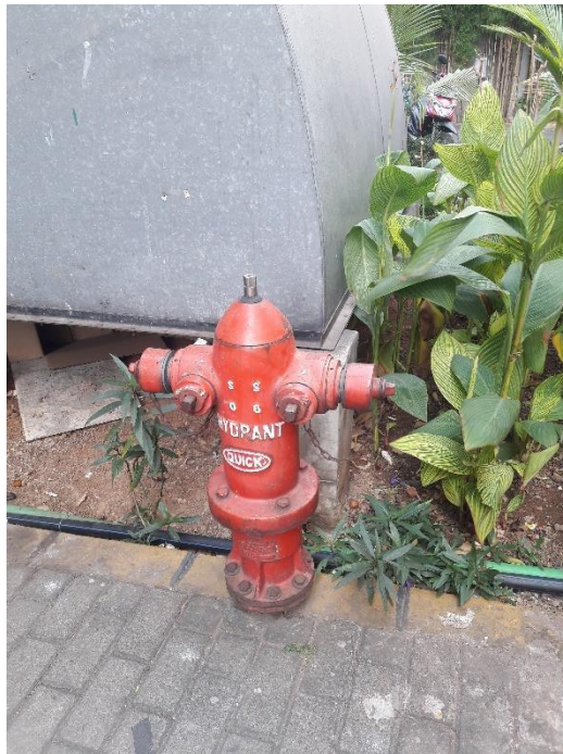
Gambar 4. 10 Hidran Halaman
