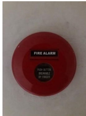
Gambar 4. 15 Alat Deteksi dan Alarm
