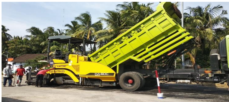
Gambar 4.4 Pekerjaan Perkerasan Aspal
