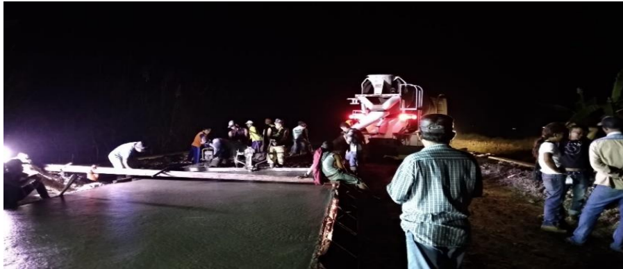
Gambar 4.5 Pekerjaan Perkerasan Beton
