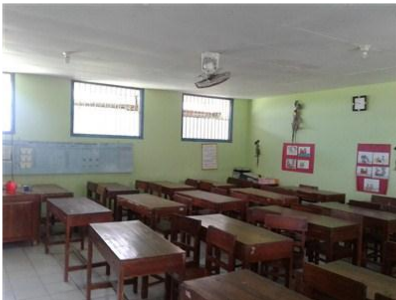
Foto 17 tampak dalam kelas yang terdapat banyak perabotan kayu yang mempercepat penjalaran api apabila terjadi kebakaran. Tidak adanya sistem pemadam kebakaran yang dapat mengurangi dampak bahaya kebakaran. Adanya ventilasi yang besar berisiko memperparah bahaya kebakaran, dan bahaya angin.
