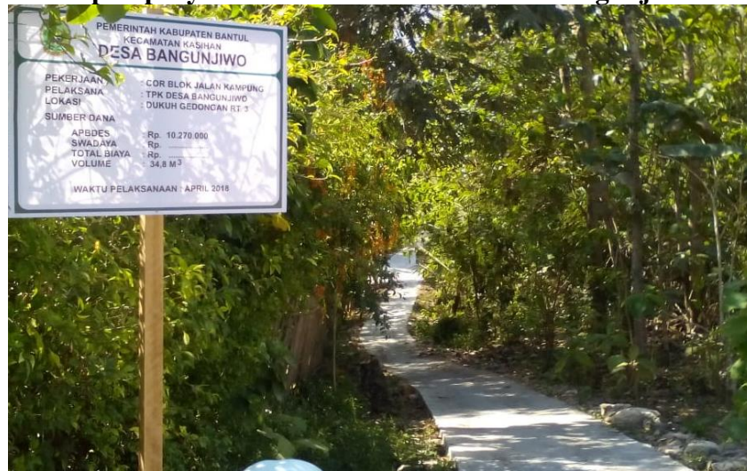
Gambar 3.7 Papan proyek Semenisasi Jalan di Desa Bangunjiwo
