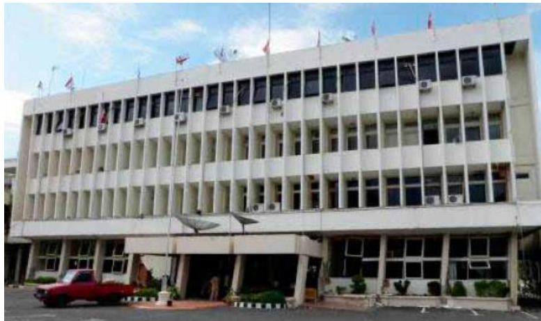
Gambar 1.5: Kerusakan struktur bangunan empat lantai akibat deformasi dan likuifaksi oleh adanya gempa bumi di Padang pada tahun 2009 (EERI Special Earthquake Report, 2009)
