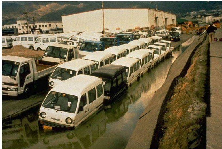
Gambar 1.6: Kerusakan fasilitas jalan berupa keruntuhan arah lateral sedalam 1,2 hingga 2 meter disertai dengan genangan air setempat akibat gempa bumi di Kobe pada tahun 1995
