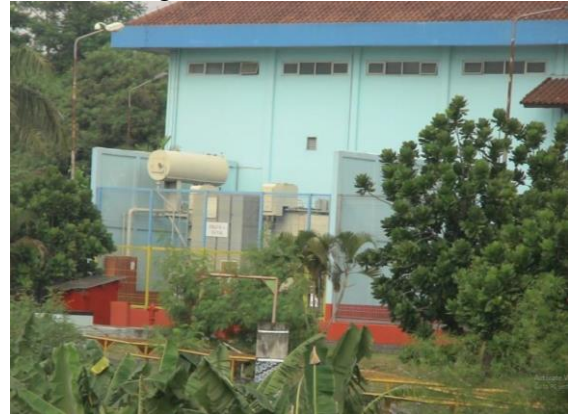
Gambar 4. Gardu Induk Pasang Setengah Luar
