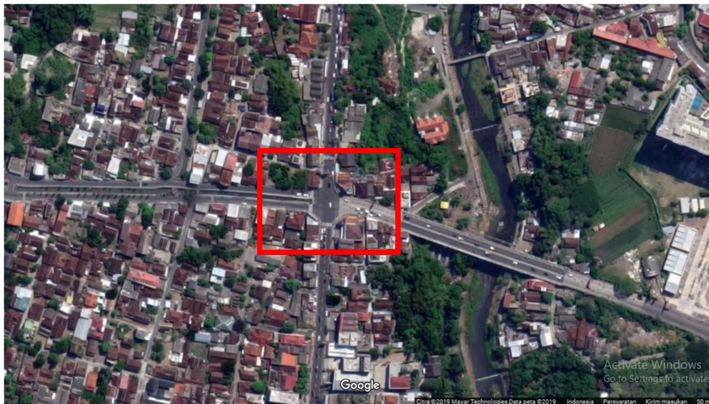
Gambar 3.3 Lokasi Penelitian Perempatan Bersinyal Gemangan (Sumber: Google Maps)
