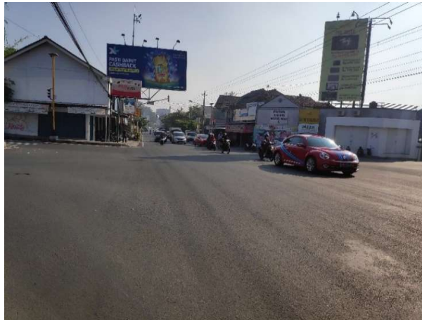
Gambar Dokumentasi 2. Kondisi Simpang Gemangan, Yogyakarta
