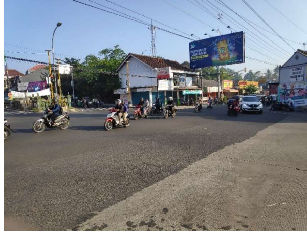
Gambar Dokumentasi 1. Kondisi Simpang Gemangan, Yogyakarta
