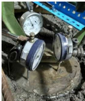
Gambar 5 Pemasangan magnetic dial gauge
