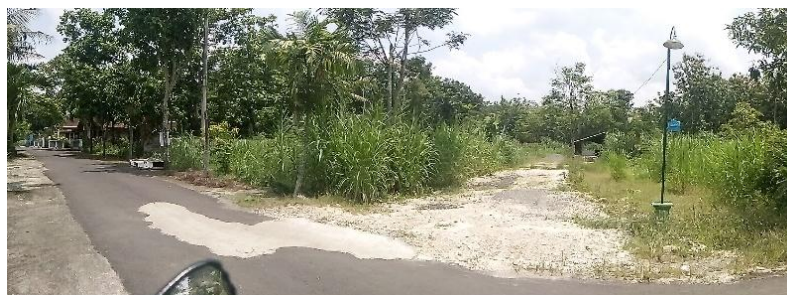
GAMBAR 5. 2 Akses Jalan Menuju Lokasi
