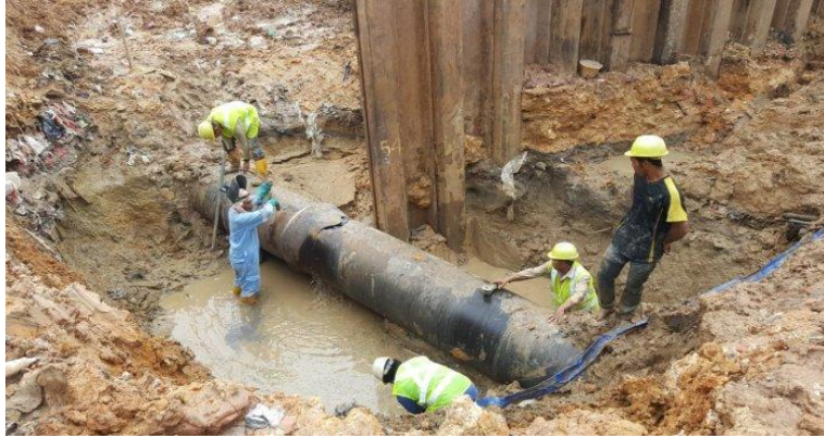
Gambar 3. 16 Proses Perbaikan Kerusakan Pipa di Batam Center
