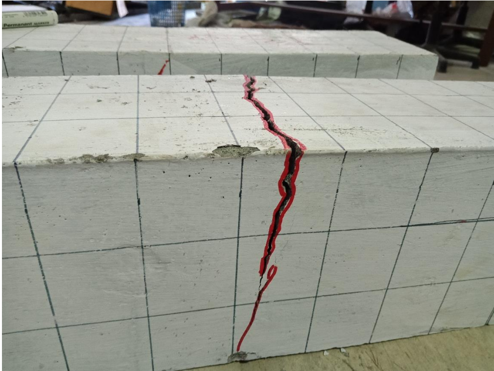
Gambar 33 beton setelah dilakukan uji tekan
