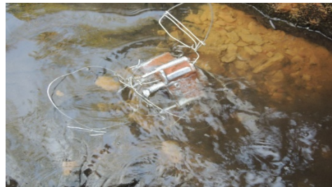
Gambar: 4.14 Pembongkaran cetakan
