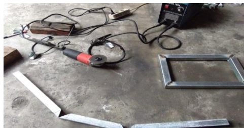
Gambar 4.2 proses pemotongan bahan konstruksi.
