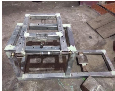
Gambar 4.6 proses pendempulan konstruksi.
