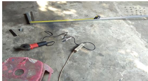
Gambar 4.1 proses pengukuran pembuatan konstruksi.
