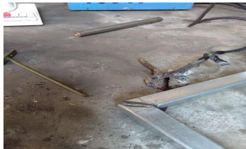
Gambar 4.4 proses penyambungan kontruksi dengan pengelasan.
