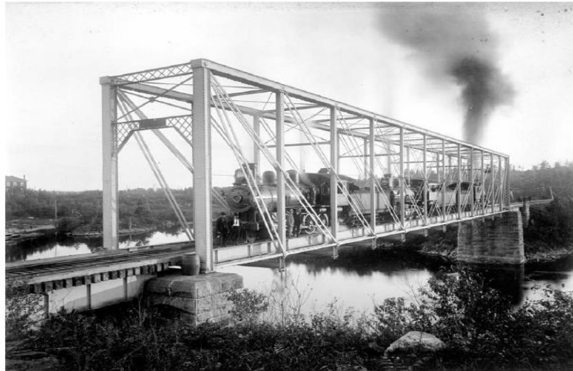
Gambar 2.4. Contoh jembatan rangka (Unsworth, 2017)
