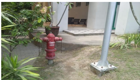
Gambar 4. 4 Hidran halaman
