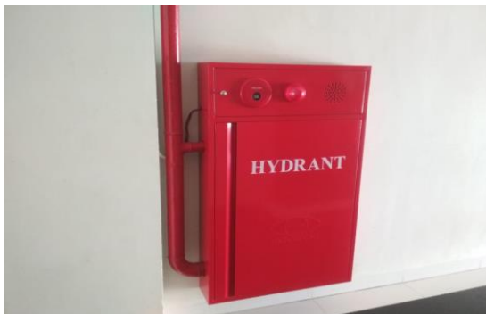
Gambar 4. 11 Hidran gedung
