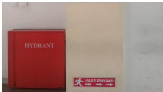
Gambar 2. 6 Hidran gedung
