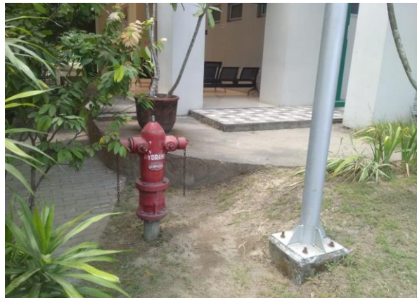
Gambar 2. 2 Hidran halaman
