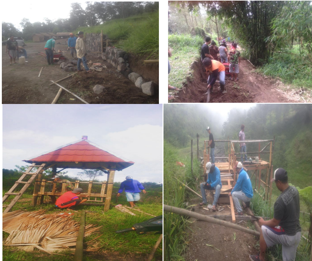
Gambar 3.2: Pembangunan Sarana Dan Prasarana Ekowisata Kali Talang Sumber :Dokumentasi anggota Pokdarwis
