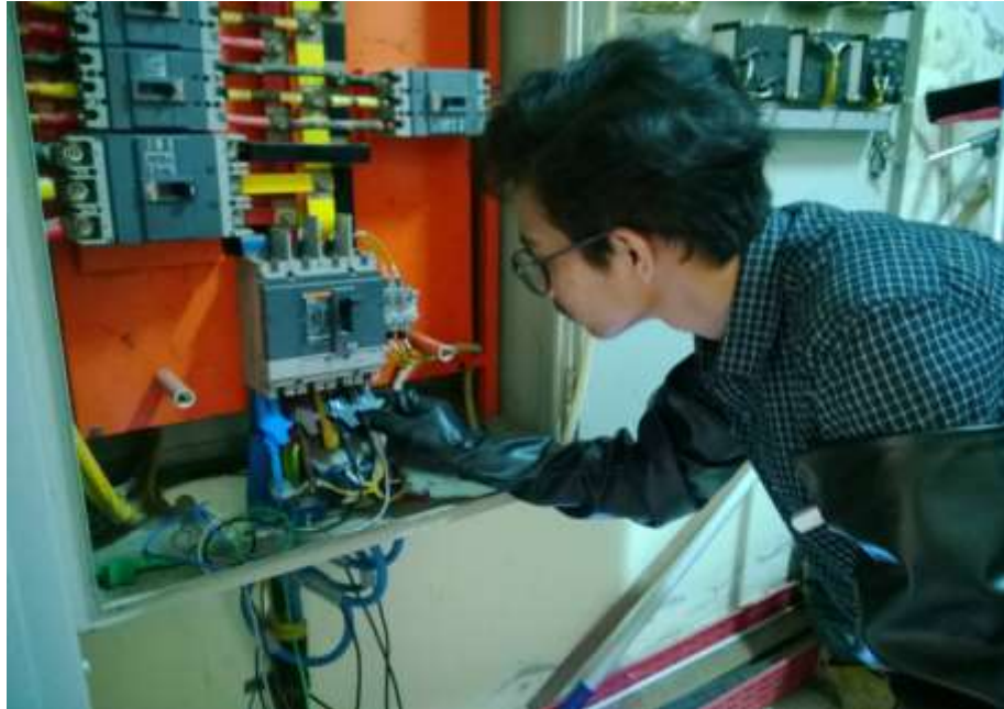
Gambar 3.3 Saat Pemasangan Alat
