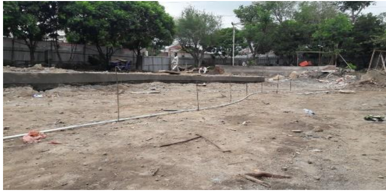
Gambar 4.2 Pekerjaan pengukuran bowplank
