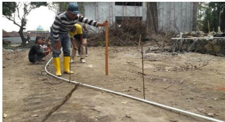
Gambar 4.3 Pekerjaan Persiapan pemasangan bowplank
