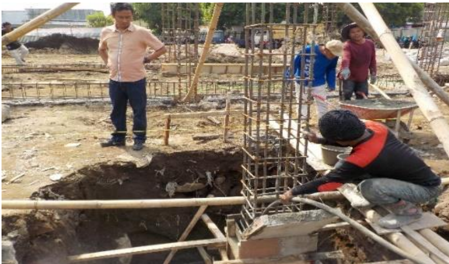
Gambar 4.5 Pekerjaan Persiapan pemasangan bekisting kolom atas
