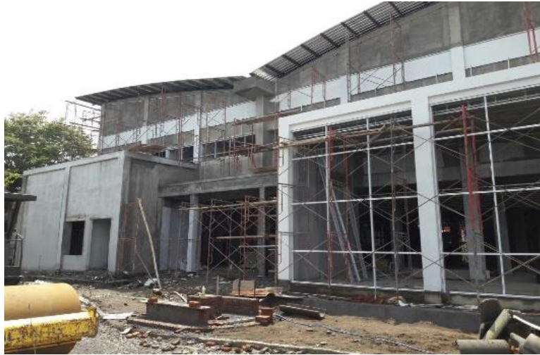
Gambar 4.3 Pekerjaan pemasangan instalasi kabel
