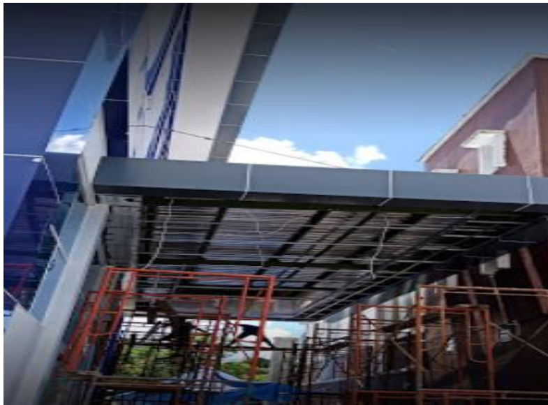
Gambar 4.6 Pekerjaan Pemasangan plafond
