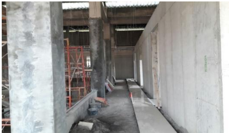
Gambar 4.3 Pekerjaan Persiapan jalur listrik
