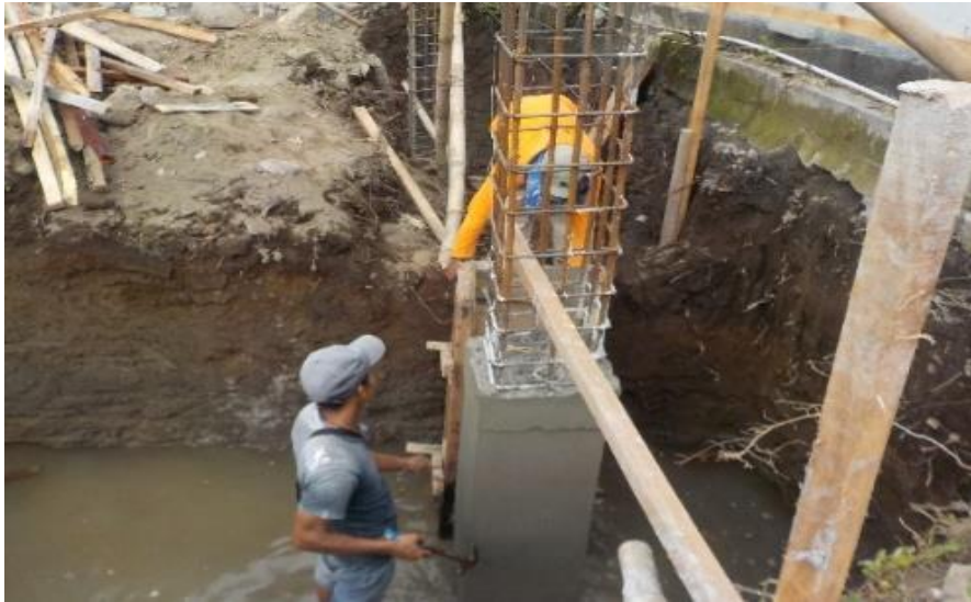
Gambar 4.4 Pekerjaan kolom struktur
