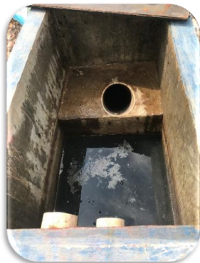
Gambar 4.4 kondisi bak pengomposan tanpa tutup (sumber : dokumentasi penulis)
