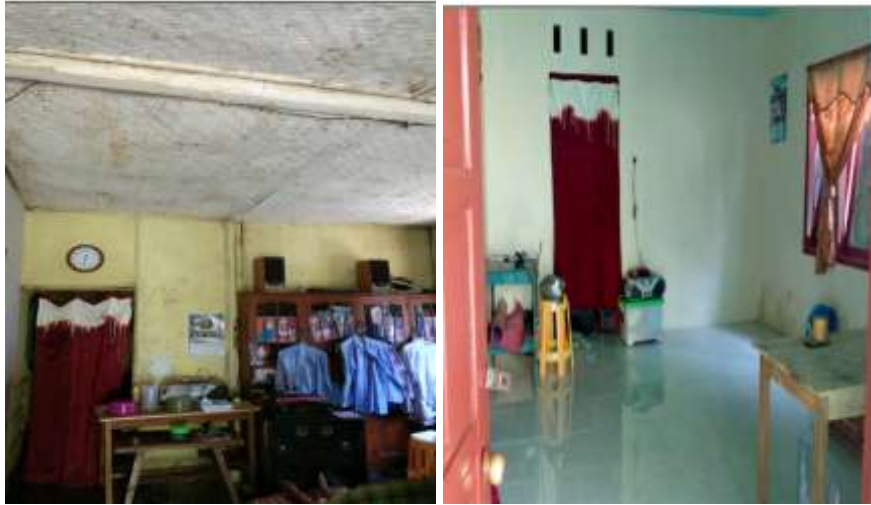
Gambar 5.1 Rumah Bapak Ahmad Nurofik Sebelum Dan Setelah Direhabilitasi
