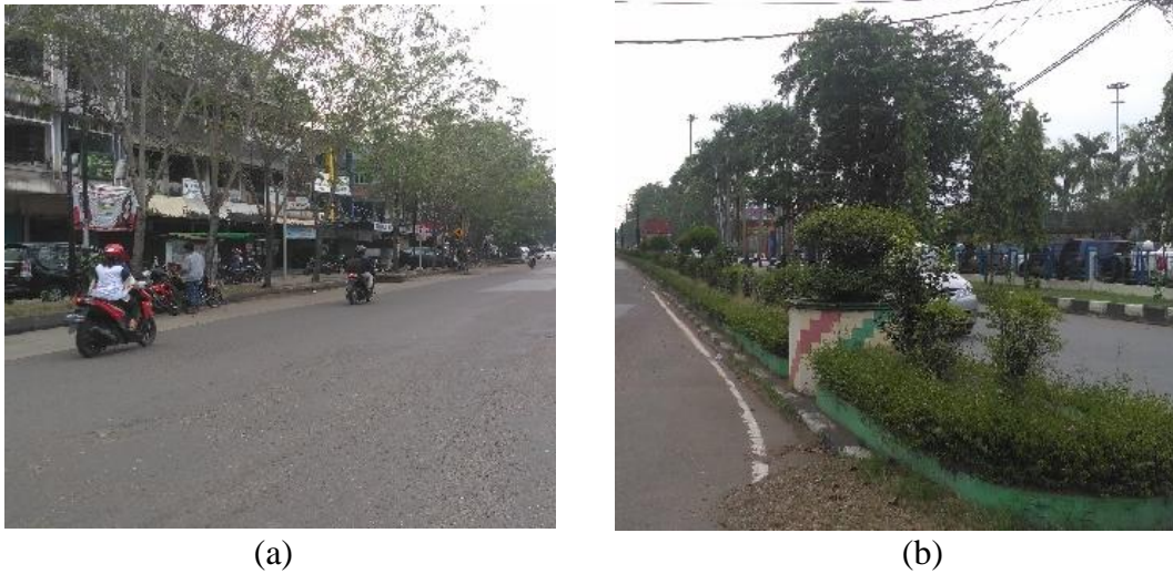
Gambar 8. Kondisi Jalan Pak Kasih: (a) Kondisi bahu jalan dan (b) Kondisi median jalan
