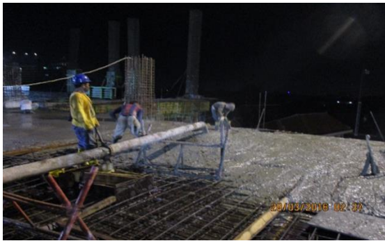
Gambar 12 Proses pengecoran balok dan plat lantai
