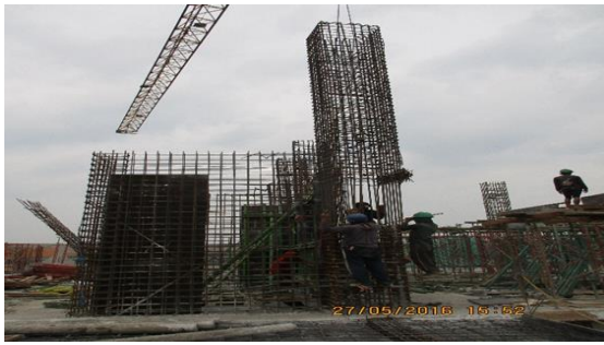
Gambar 5 Proses pemasangan tulangan kolom
