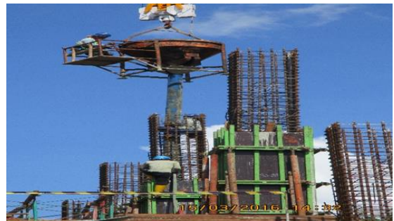
Gambar 7 Proses pengecoran kolom
