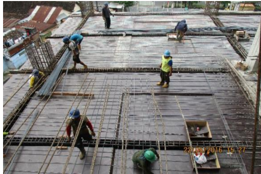
Gambar 10 Proses pembesian plat lantai
