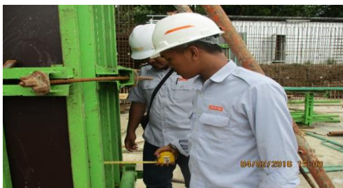
Gambar 6 Proses pengecekan vertical kolom
