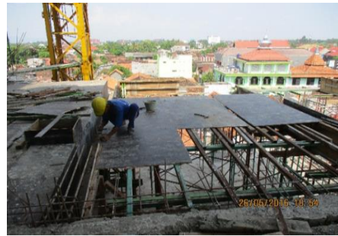
Gambar 11 Proses pembekistingan plat lantai
