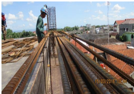
Gambar 8 Proses pembesian balok
