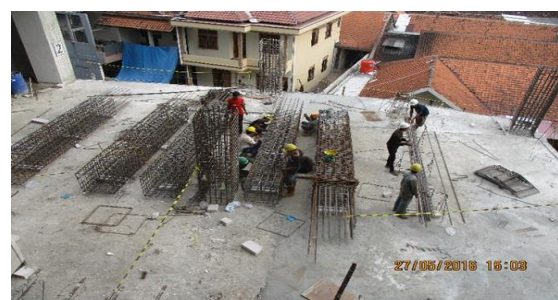
Gambar 4 Proses perakitan tulangan kolom
