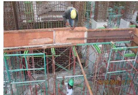
Gambar 9 Proses pembekistingan balok
