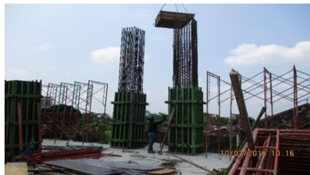
Gambar 4.8 Proses pembekistingan kolom
