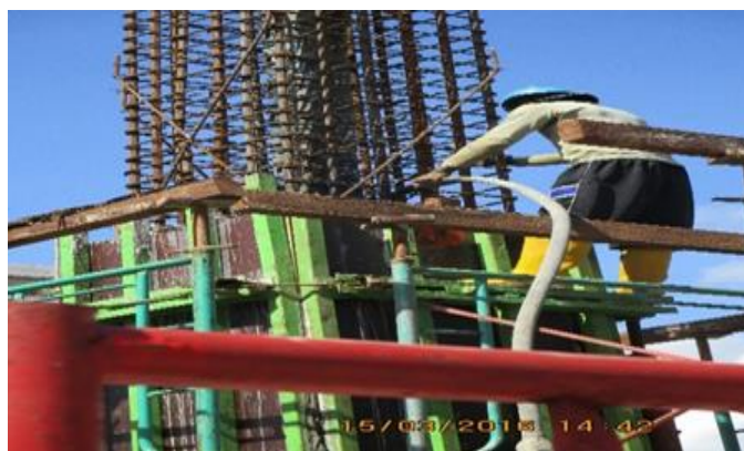
Gambar 4.11 Proses pengecoran kolom
