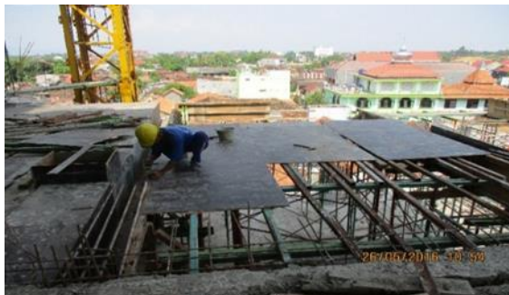
Gambar 4.17 Proses pekerjaan pembekistingan plat lantai
