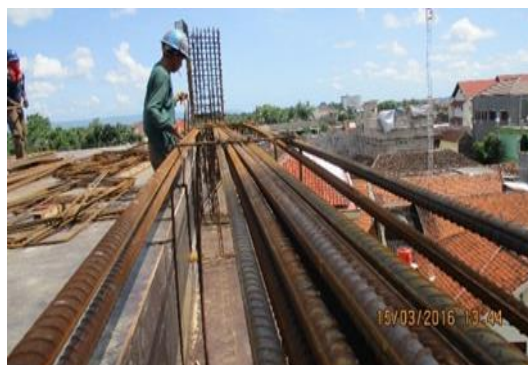
Gambar 4.14 Proses pekerjaan pembesian balok
