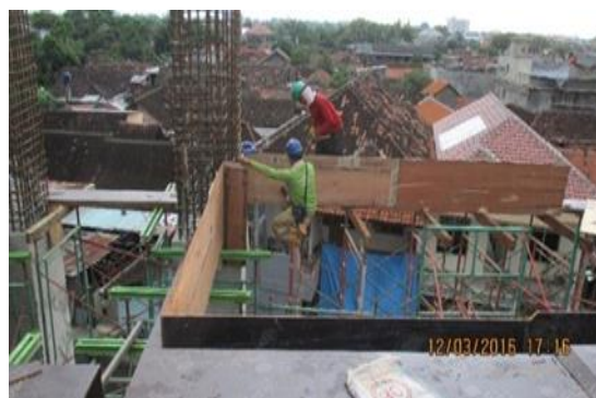
Gambar 4.12 Proses pekerjaan pembekistingan balok
