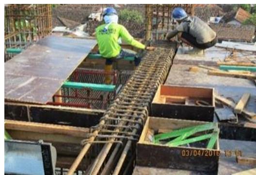
Gambar 4.15 Proses pekerjaan pembesian balok
