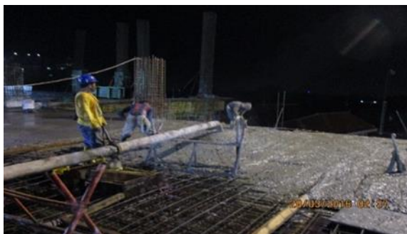
Gambar 4.20 Proses pekerjaan pengecoran plat lantai
