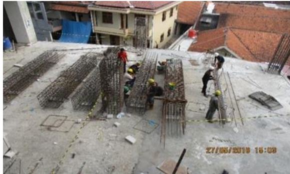
Gambar 4.6 Proses perakitan tulangan kolom
