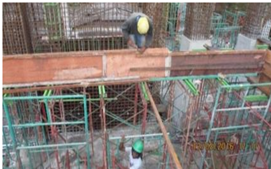
Gambar 4.13 Proses pekerjaan pembekistingan balok
