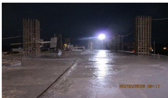
Gambar 4.21 Proses pekerjaan pengecoran plat lantai
