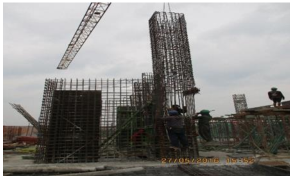
Gambar 4.7 Proses pemasangan tulangan kolom
