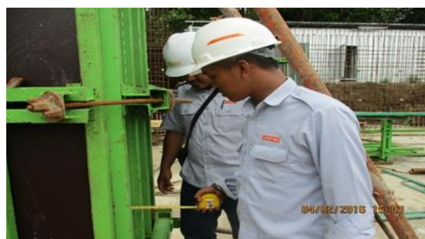
Gambar 4.9 Proses pengecekan vertikal kolom
