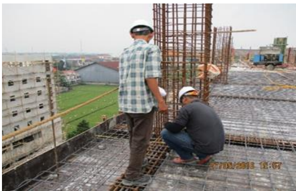
Gambar 4.5 Proses pengendalian mutu pekerjaan
