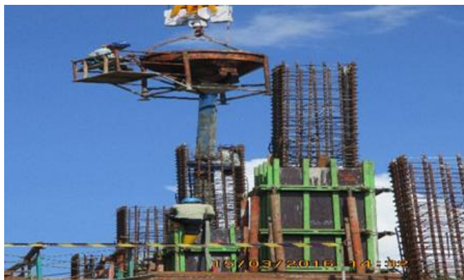
Gambar 4.10 Proses pengecoran kolom
