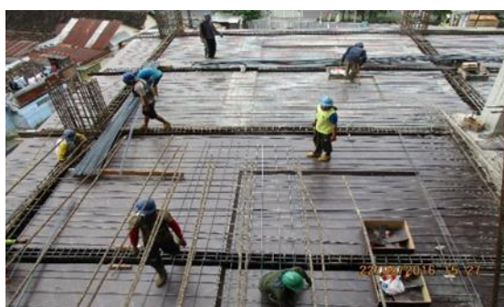
Gambar 4.18 Proses pekerjaan pembesian plat lantai
