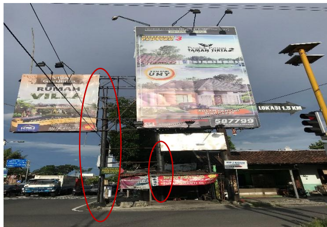
Gambar 4.6 Contoh tinggi tiang utama baliho berukuran besar dan kecil (Sumber: Dokumentasi Survey)
