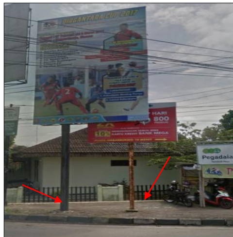
Gambar 4.52 Baliho yang dibangun di atas trotoar
