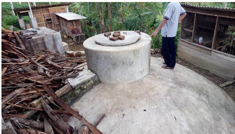
Gambar 1. IPAL untuk menampung limbah tahu.
