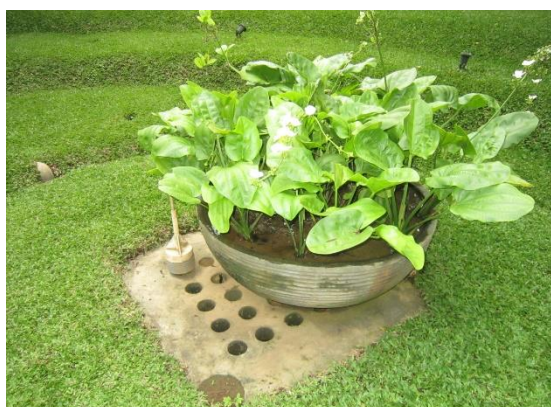
Gambar 14 Sumur Resapan Air
