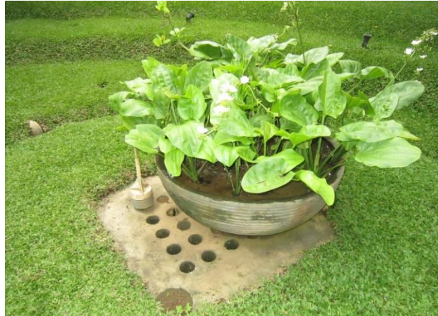
Gambar 4.6 Sumur Resapan Air
