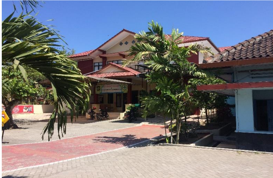
GAMBAR 3.8 GEDUNG UPTD PUSKESMAS NANGGULAN
