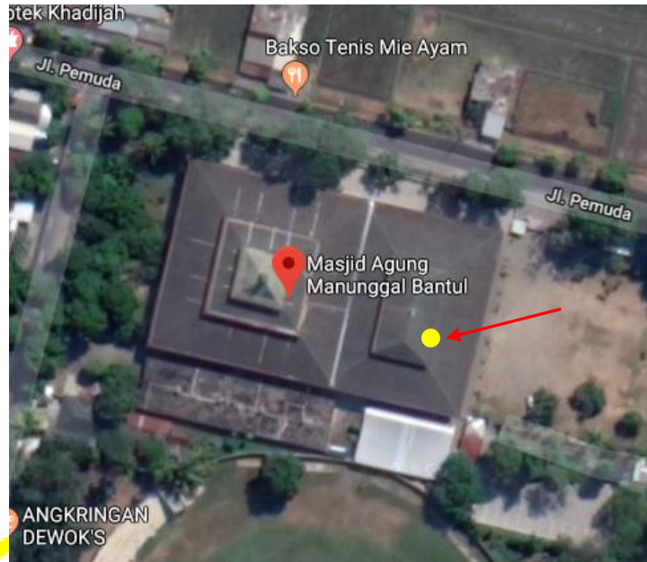
Gambar 4.25 Posisi Pengujian Alat di Masjid Agung Manunggal Bantul
