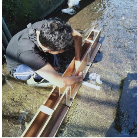
Gambar 3.10 Menambal bagian yang berlubang
